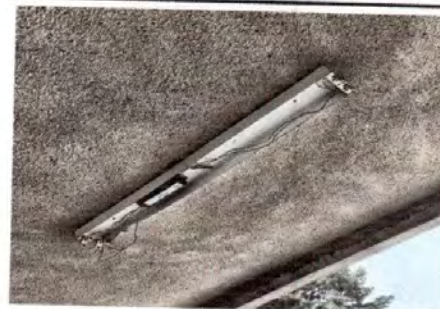
Foto 24: Reparación de cableado electrico.
