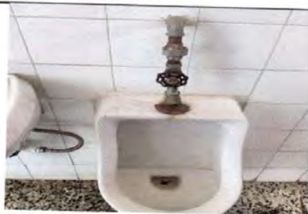
Foto 17: Sustitución de migitorio.
