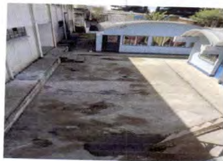
Foto 20: Reparación de plancha de concreto de patio
