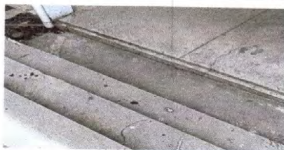
Foto 12: Sustitución de soporte de metal para canal.
