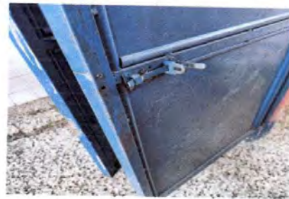
Foto 2: Lijado y aplicación de pintura
