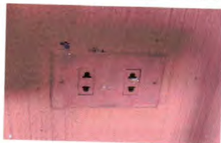
Foto 23: .Sustitución de tomacorriente doble.
