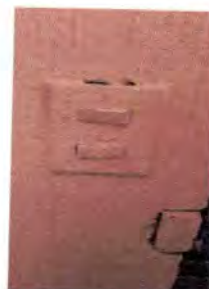
Foto 22: sustitución de Interruptores simples e interruptores dobles
