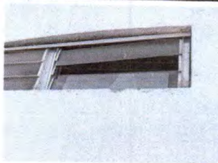
Foto 8: Sustitución de vidrios.
