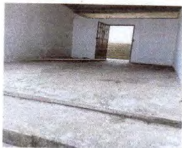
Foto 11: Sustitución de piso de torta de concreto (Piso de granito).
