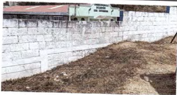
Foto 19: Reparación de muro perimetral con tubo HG y malla galvanizada.
