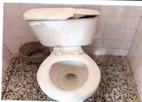
Foto 15: Sustitución de inodoros.
