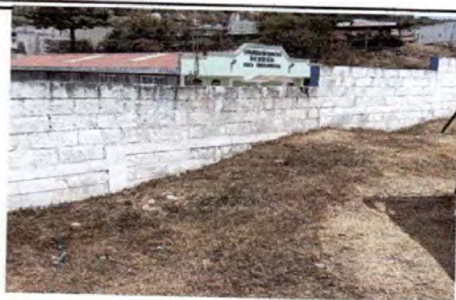
Foto 13: Pintura en muros interiores y exteriores.
