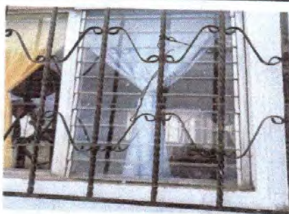
Foto 9: Mantenimiento a balcones de metal.
