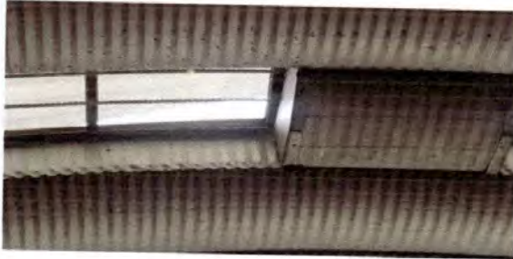
Foto1: Sustitución de lámina por lámina policarbonato de 12"
