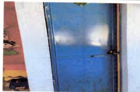
Foto 4: sustitución de chapa bola
