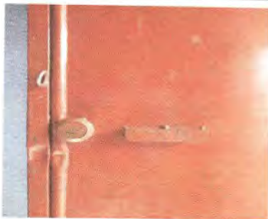
Foto 3: sustitución de chapa
