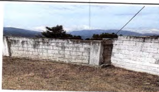
Foto 18: Reparación de muro perimetral de block.
