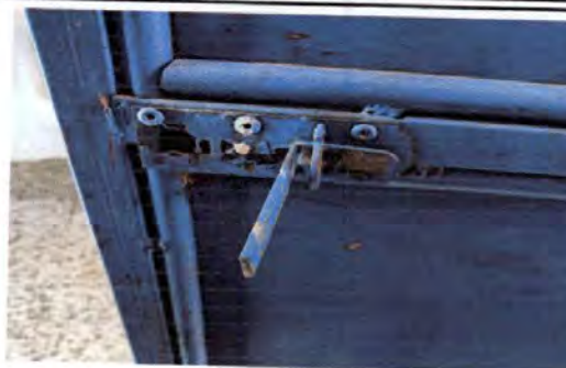
Foto 14: Mantenimiento a estructura, lijado, aplicación de pintura, sujeciones, arreglo a puerta de servicios sanitarios.
