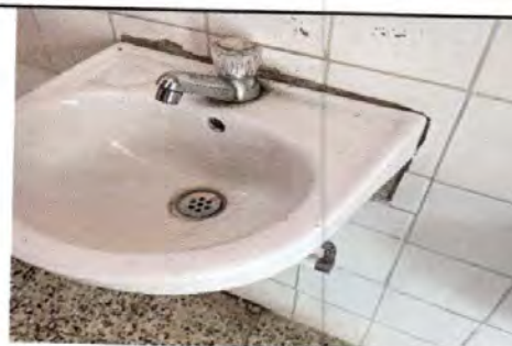
Foto 16: Sustitución de lavamanos y azulejo
